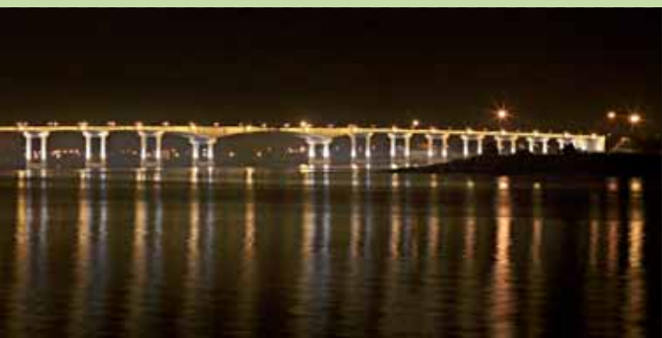
Ponte da Barra
